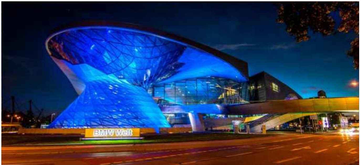
Das Dach der BMW-Welt in München: Die Werkstattplanung der Stahlkonstruktion stammt aus Muck's Feder.
