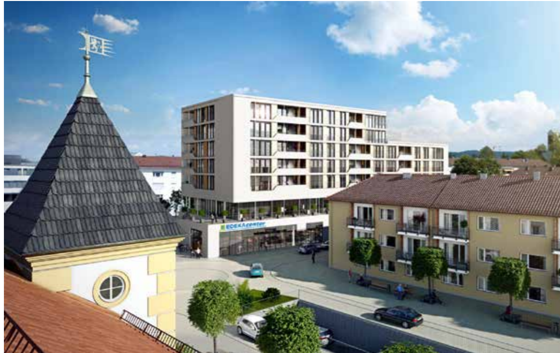
Das Puls G – ein Mischgebäude mit 13.000 m 2 Bruttogeschossfläche – bildet das Herz des Quartiers, der „Neuen Mitte“ von Geretsried. Hier begannen die Bauarbeiten im Sommer 2017.
